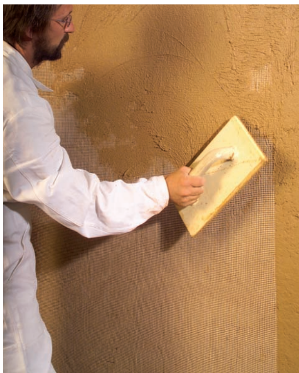
Abbildung 6.1.3: Sorgfältiges Einarbeiten der Armierung mit dem Schwammbrett
