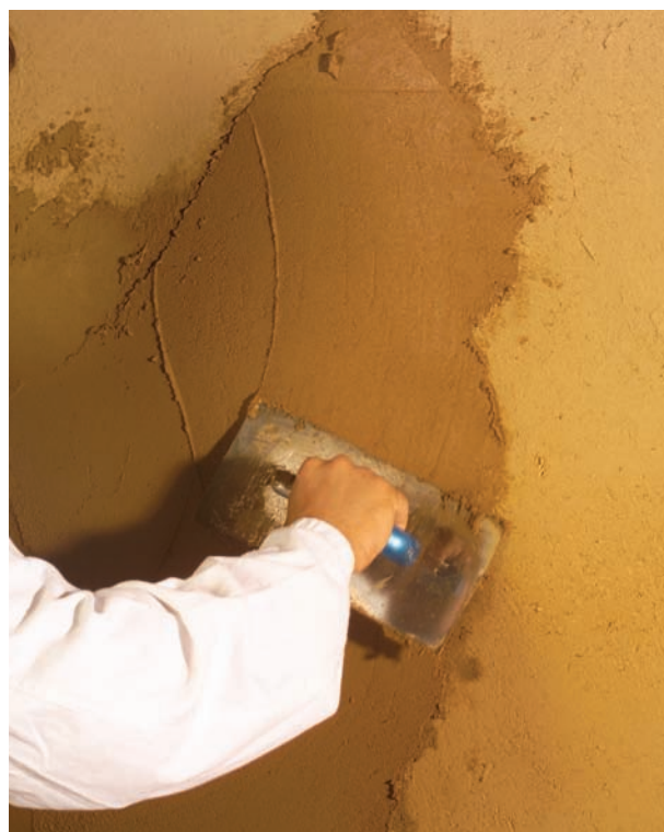
Abbildung 6.1.4: Nach der Trocknung Auftrag von Lehm-Oberputz fein mit dem Edelstahlglätter, Auftragsdicke 2-3 mm
