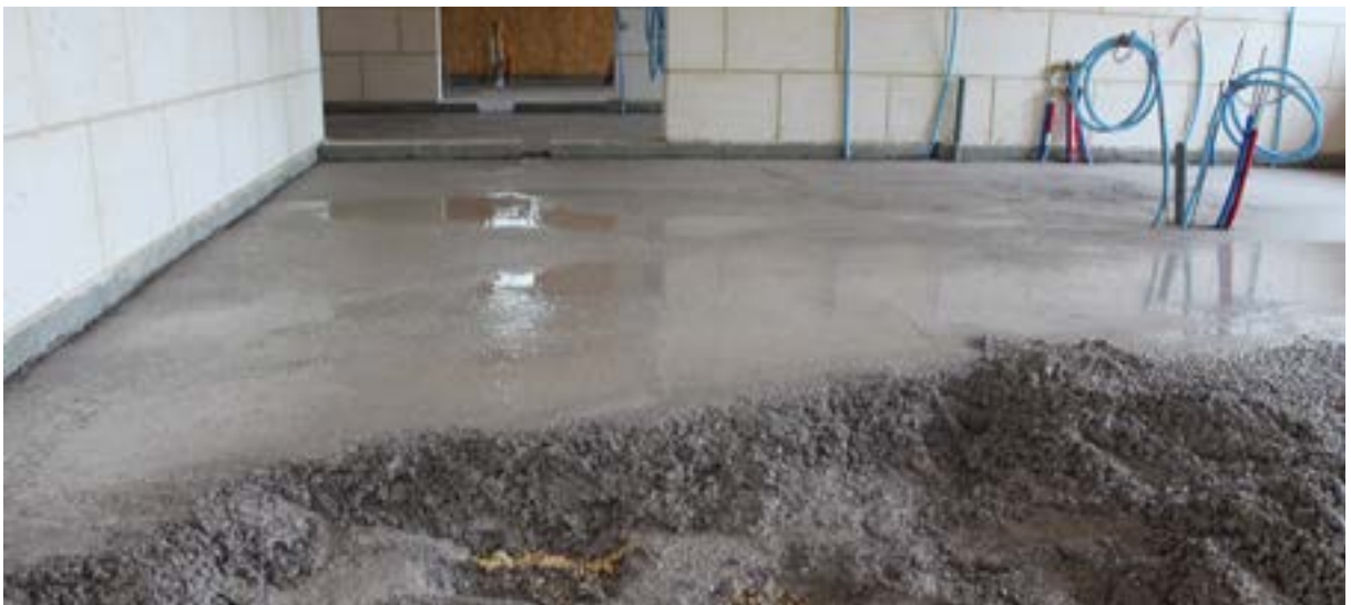
Bodenbelag aus Kalkestrich mit Estrichkies, auf gestampftem Untergrund.
